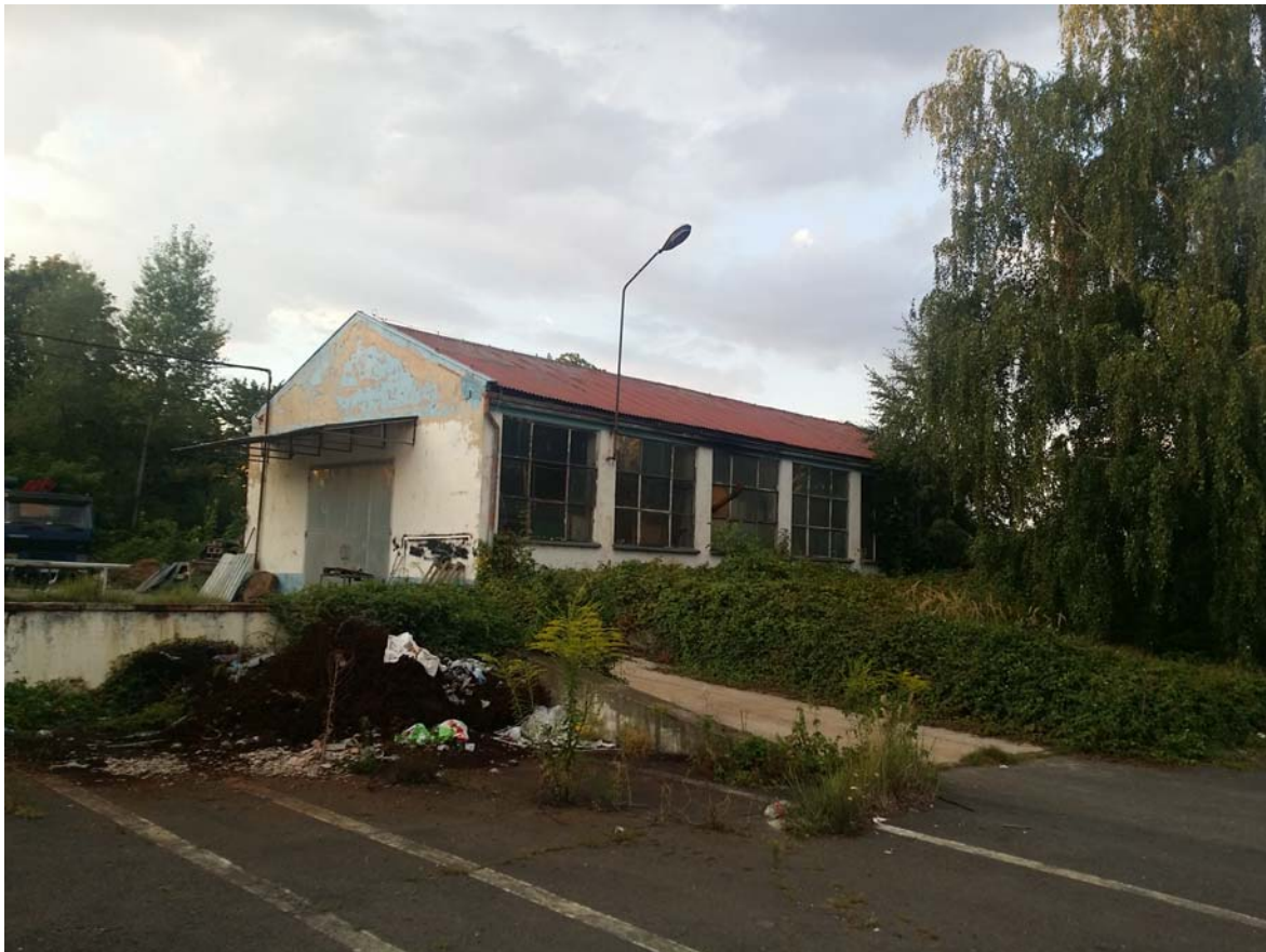
obiekt nr 101. Magazyn silników
