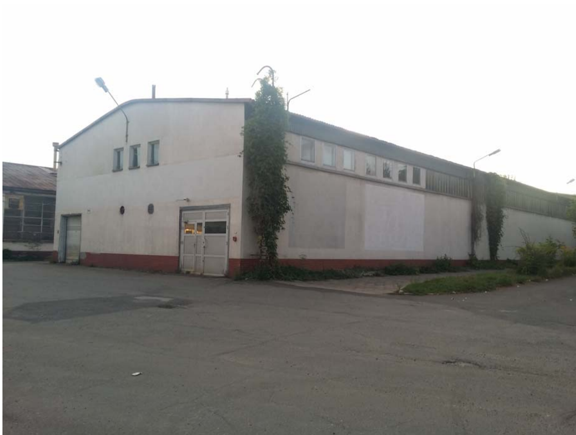
obiekt nr 103. PR-5 Montażownia końcowa Truck
