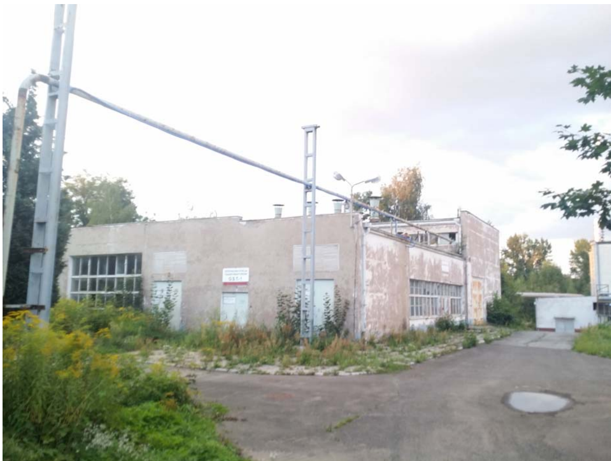
obiekt nr 114. Kompresorownia
