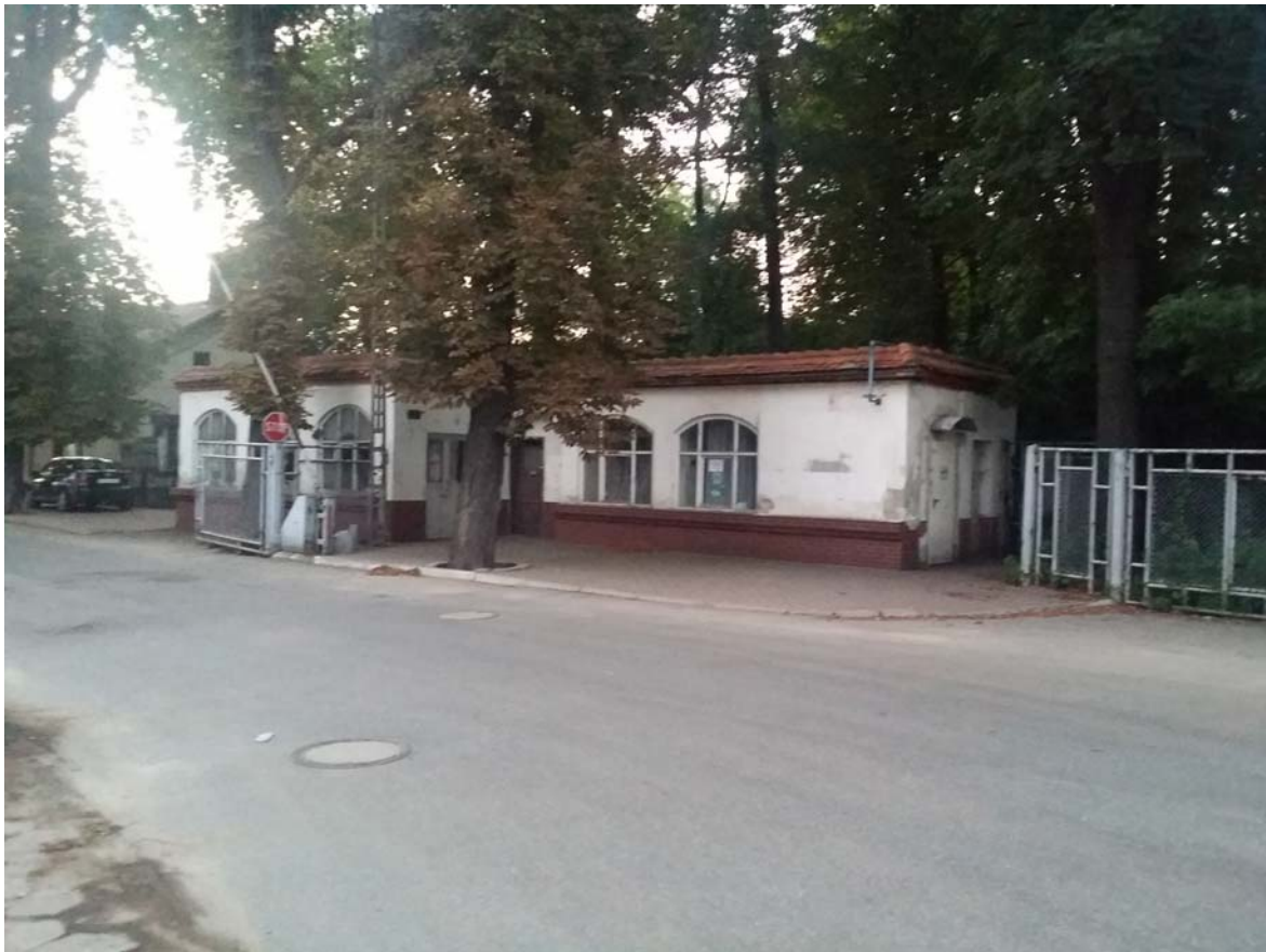
obiekt nr 6. Biuro przepustek
