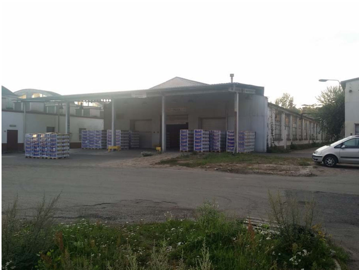
obiekt nr 29. PR-5 Montażownia Truck
